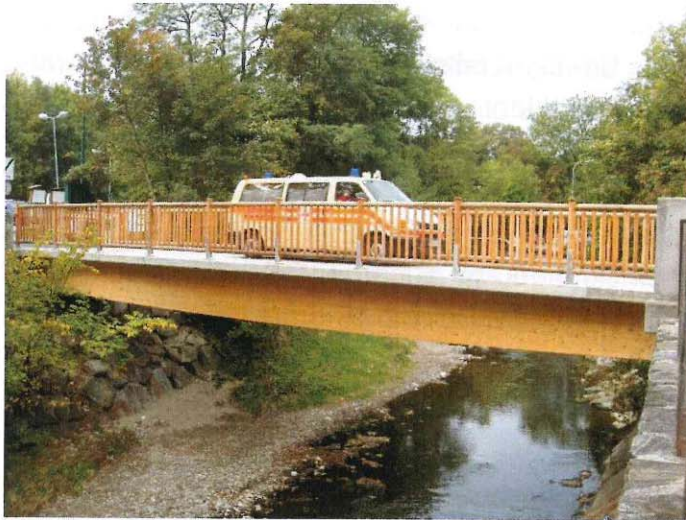
Bild 5 Fußgängerbrücke bei Wien, Spannweite 17,5 m ( www.hbv-systeme.de )
