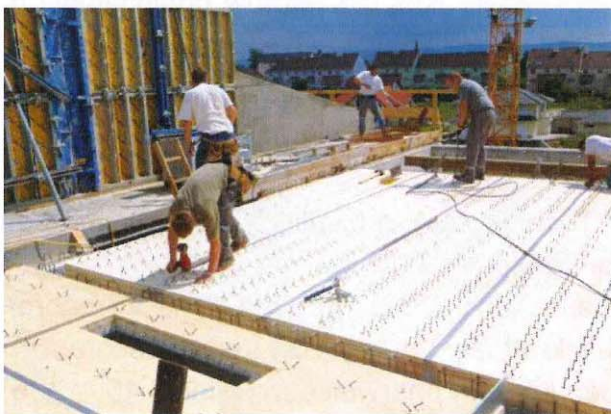
Bild 3 Brettsperrholz- Beton- Verbundplatte für Geschoßdecken eines Altenheims mit Oberflächenfertiger Lärchenholzunterseite (Dicke der Brettsperrholzplatten 120 ... 170 mm), (Foto: SFS intec GmbH)
